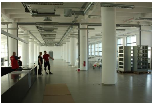
Ústřední knihovna – stěhování nábytku po opravě podlahy ve 4. podlaží
