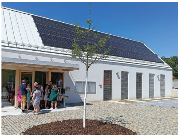
Multifunkční centrum s knihovnou v Rudimově
